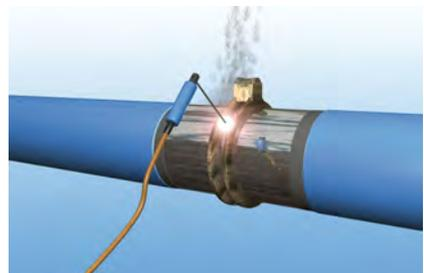
deux passes minimum (les soudures peuvent être réalisées en une seule passe en cas de soudage autogène au gaz et pour une épaisseur de paroi maximum d'environ 3,6 mm). La soudure doit être réalisée rapidement et sans interruptions notables jusqu'à la passe de finition.
