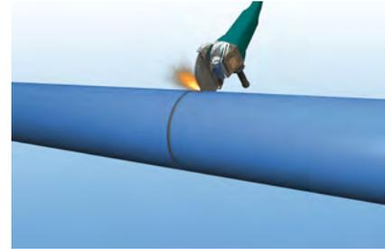
2. Pour enlever le mortier de fibrociment, par ex. à l'extrémité des tubes raccourcis ou pour mettre en place les colliers de prise avec vanne intégrée sur le revêtement extérieur en polyéthylène, inciser le revêtement extérieur en mortier de fibrociment antiroche sur toute la circonférence du tube et sur la longueur à enlever.
