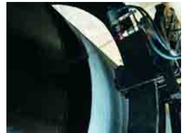
Rénovation avec les revêtements au polyuréthane
