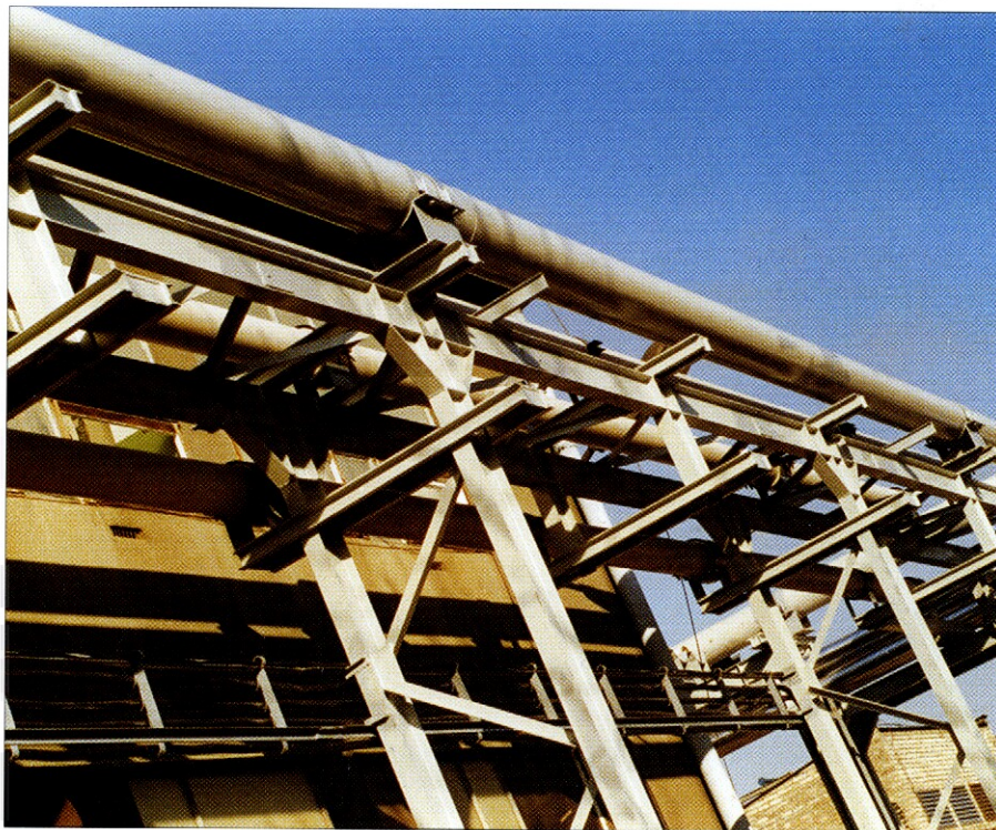
Conduite DN 200, PN 6 posée en élévation
