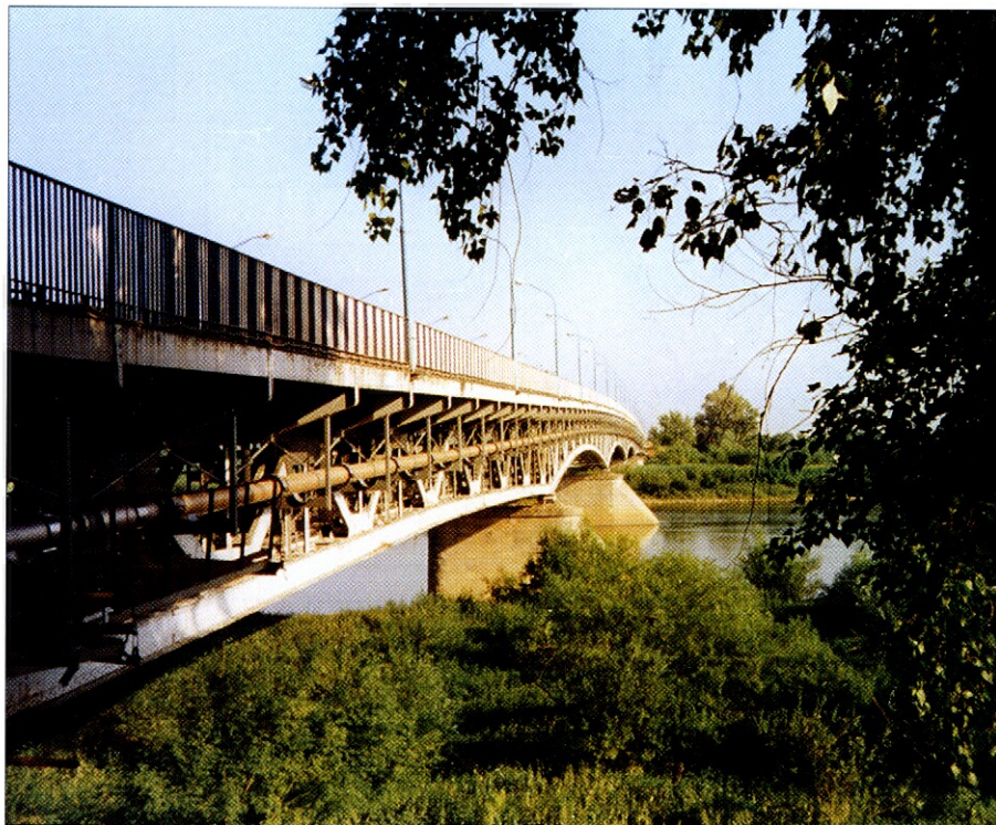
Conduite DN 350, PN 10 posée sous un pont
