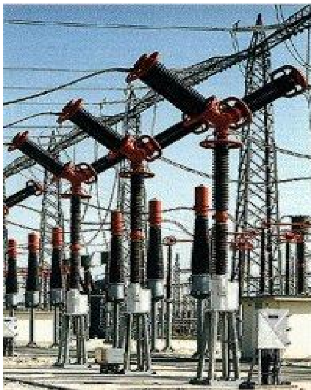
Disjoncteurs HTB pour postes aériens (125kV).
