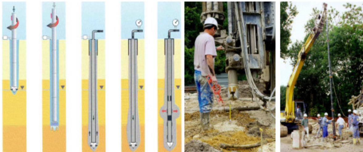
Figure 2-11 : Réalisation d'un micropieu pour les écrans antibruit de l'autoroute A4 (photographies S. Borel) [21]
